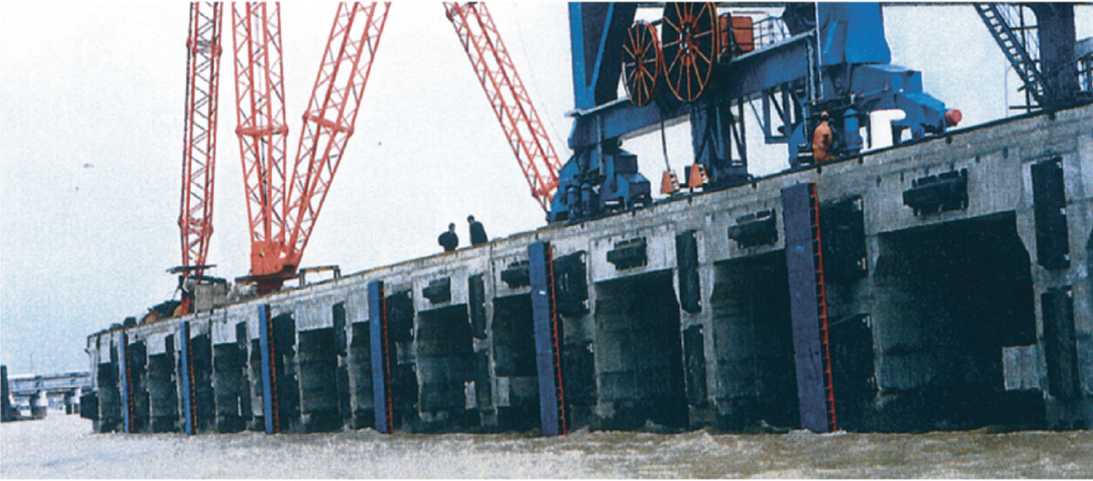
◆ 上海漕泾电厂二期码头 SA-B800
