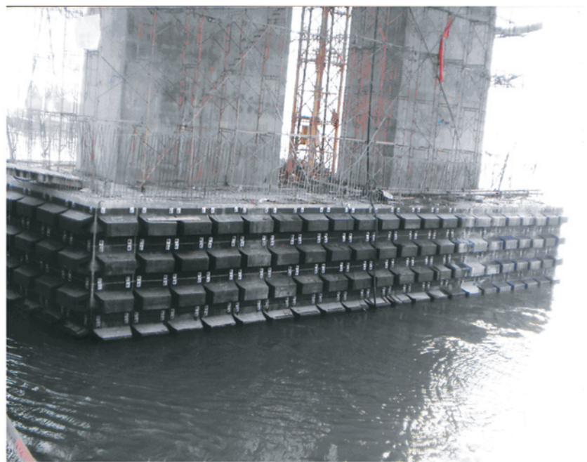
◆ 温福高铁白马河特大桥 SA-A500
